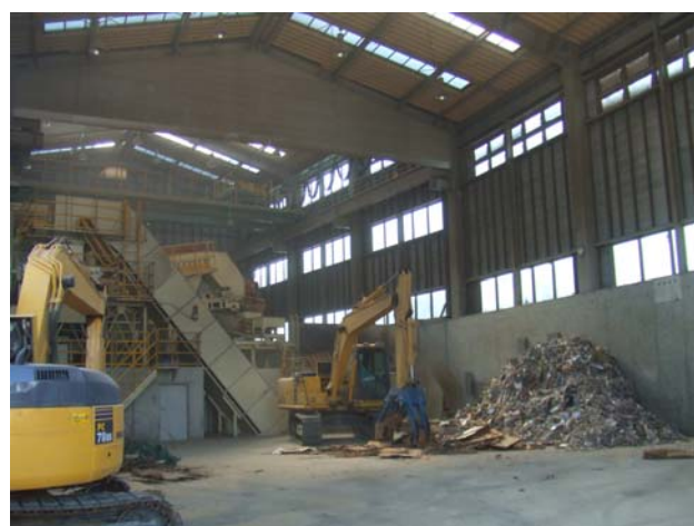
バイオマス受け入れ場
