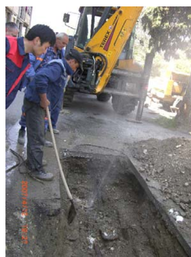
漏水ポイントの掘削—噴きあがる水
