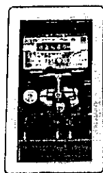
写真2: 買電量と売電量のメータ
