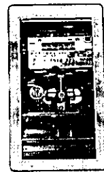
写真2: 買電量と売電量のメータ
