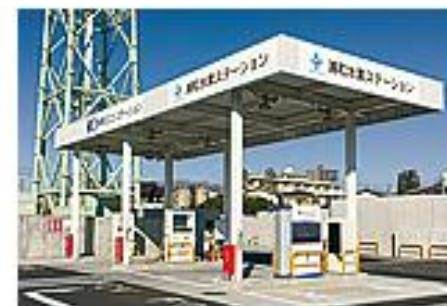
浦和水素ステーション
